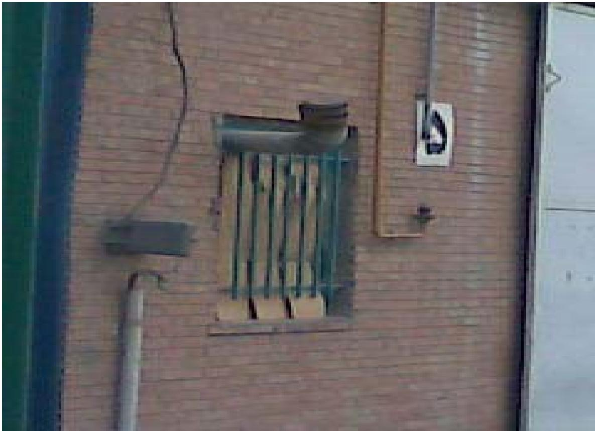
۵. علیرغم توضیحات بخش قبلی، عبور دادن لوله دودکش از پنجره صحیح نبوده و خطرات خاص خود را دارد. این کار علاوه بر احتمال برخورد پرده با دودکش و ایجاد حریق، عواقب دیگری دارد از جمله اینکه، باز و بسته شدن پنجره باعث شل شدن اتصالات می‌گردد. ترک برداشتن شیشه بر اثر گرما و احتمال ریختن آن نیز باعث حادثه می‌گردد.
